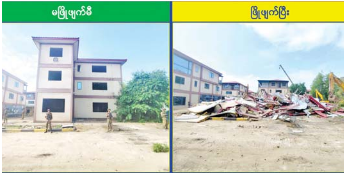
ကရင်ပြည်နယ် မြဝတီမြို့နယ် ရွှေကုက္ကိုလ်နယ်မြေ၌ အွန်လိုင်းလိမ်လည်လောင်းကစားမှုများ လုပ်ကိုင်ခဲ့သည့် တရားမဝင်အဆောက်အအုံများအား မဖြိုဖျက်မီနှင့် ဖြိုဖျက်ပြီးနောက် တွေ့ရစဉ်။
